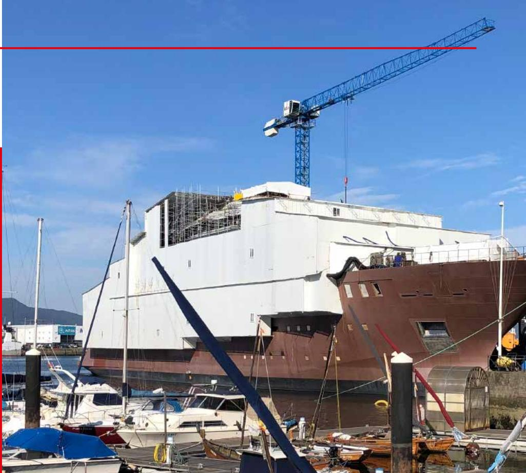
Au cœur du chantier naval Freire de Vigo, en Galice (Espagne), nos équipes contribuent à monter une structure d'échafaudage Plettac Futuro pour mener à bien des travaux d'importance sur un méga yacht de très grande envergure : 112 mètres de long sur 18 mètres de large. La maintenance de ce navire constitue véritablement un projet significatif et fait d'ailleurs bénéficier ALTRAD d'une grande visibilité sur le marché de la construction navale en Espagne.
