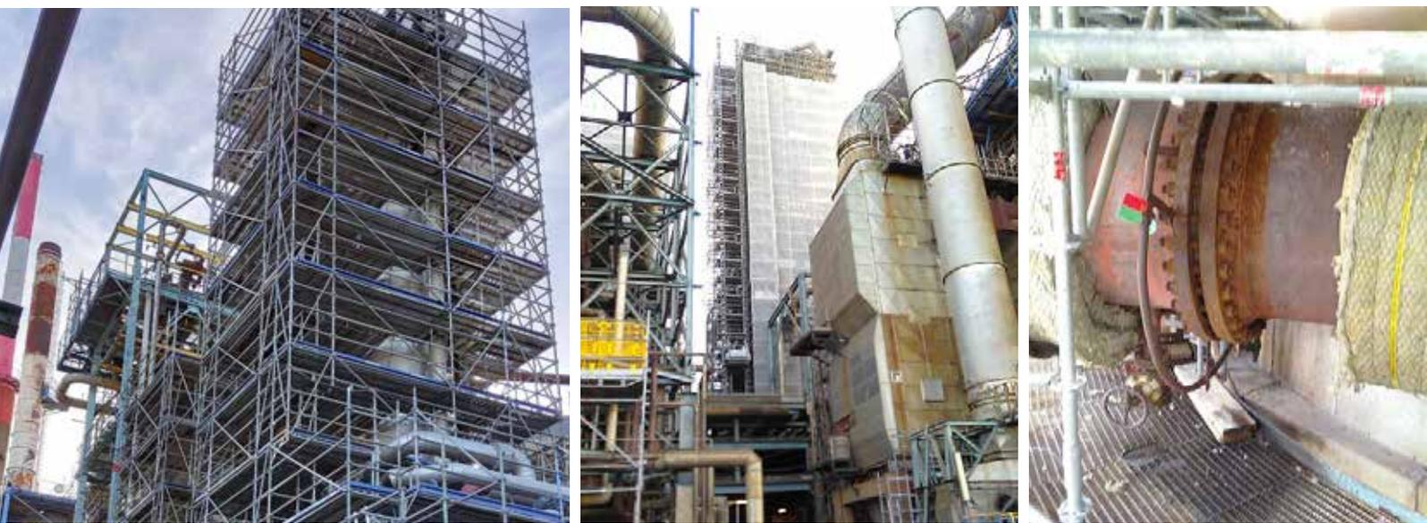
Pour la BU Grands Projets, les travaux étaient principalement situés sur les deux colonnes de l'unité DEE, la C-1001 et la C-2001, avec 470 tonnes d'échafaudages, ainsi qu'au niveau des fours de l'unité VISCO. La préparation du projet et les relevés ont démarré pour la BU Grands Projets de Prezioso Linjebygg dès fin juin 2021.
